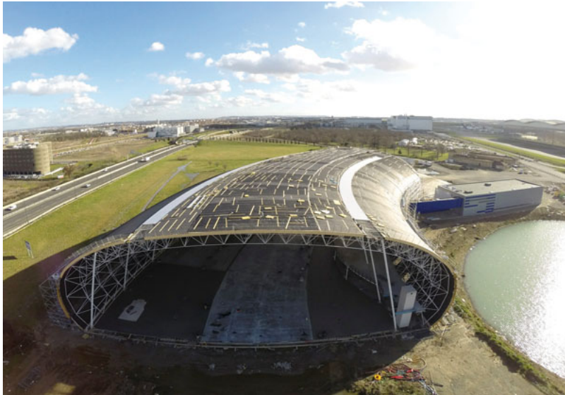
Prouesse architecturale, le bâtiment
