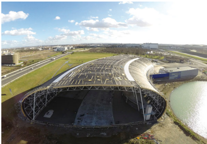
Prouesse architecturale, le bâtiment
