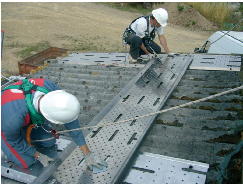
Le plancher Securiplac (2008)
