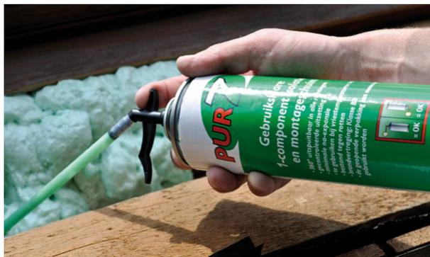
Pour assurer l'étanchéité à l'air d'un bâtiment, les
