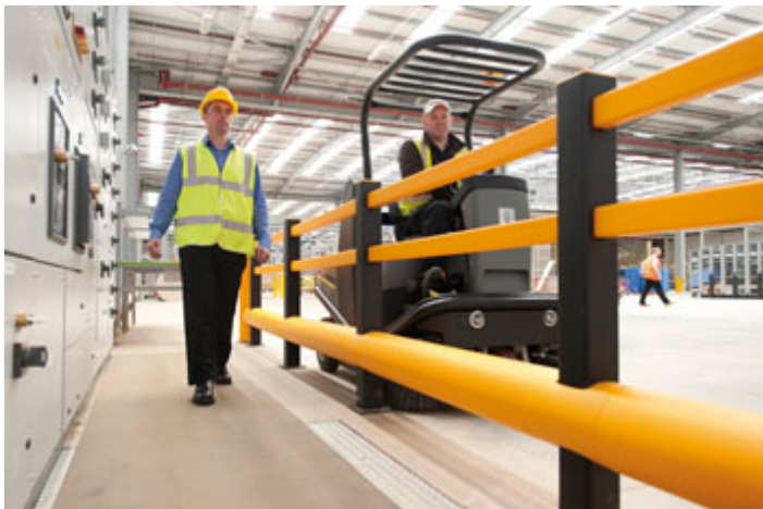
Les collisions dans un bâtiment industriel ou
